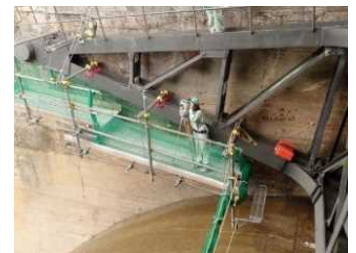
洪水吐ゲート点検
