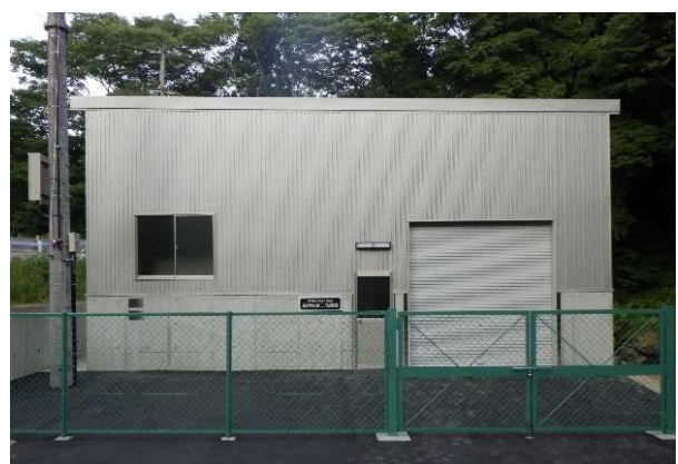
上松駒ヶ岳発電所
