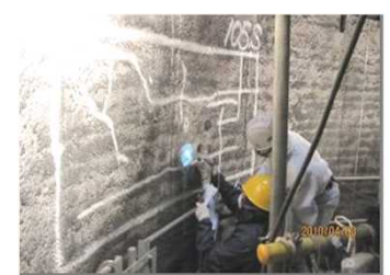
煙突の内部点検
